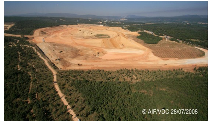
Cadarache (Francia): sito ITER
